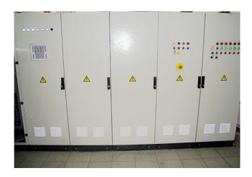
Печи средней степени автоматизации комплектуются расширенной системой управления, которая базируется на центральном контроллере И промышленном компьютере. На базе промышленного компьютера устанавливается система данных, сбора которая позволяют вводить, впоследствии сортировать данные οб изделии, номенклатуре, массе, дате термообработки или имени оператора. Кроме того, могут они хранить
