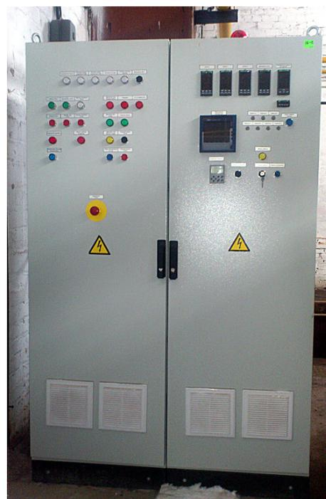
Все силовое оборудование (пускатели, автоматы защиты двигателей и др.) размещено в силовом шкафу в зоне установки печи. Силовое оборудование большой мощности снабжено системой обеспечивающей минимальное влияние на электросеть цеха для соответствия требованиям стандартов по ЭМС.
