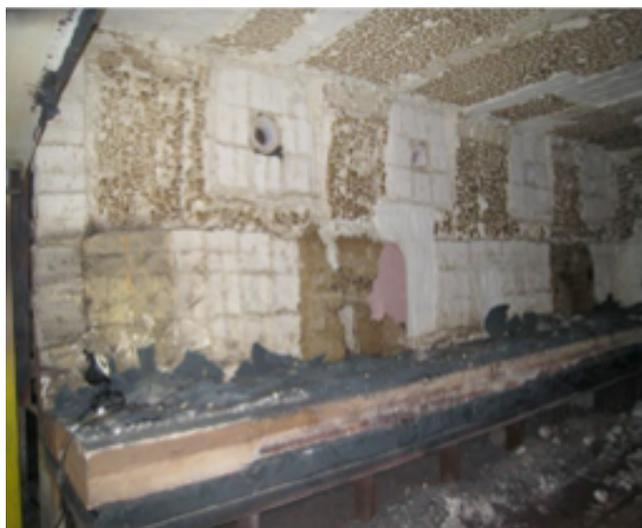
Рисунок 1: СОСТОЯНИЕ ИЗОЛЯЦИИ ДО РЕМОНТА
